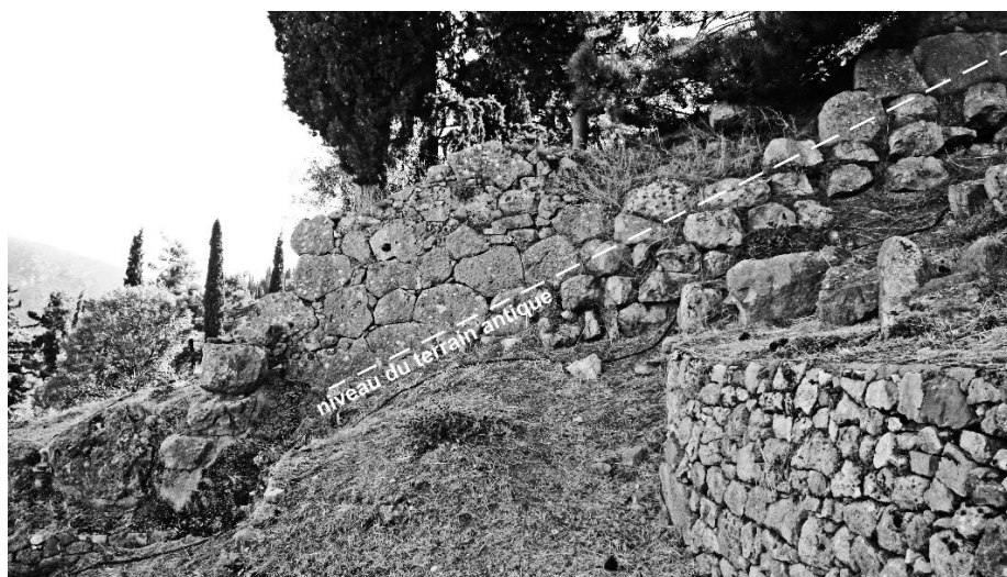
Fig. 4 : Déchaussement du mur d'enceinte ouest du sanctuaire d'Apollon avec présence de murs de soutènement modernes qui perturbent la compréhension de la topographie antique du site.
